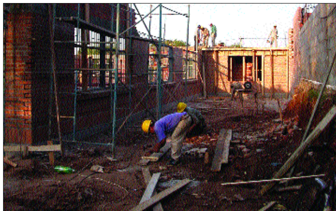
Estado de las obras del proyecto en el barrio de San Gerardo. FP
